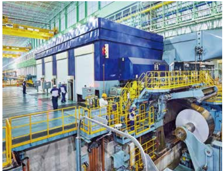
4スタンド熱間仕上圧延機
