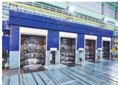
4スタンド熱間仕上圧延機
