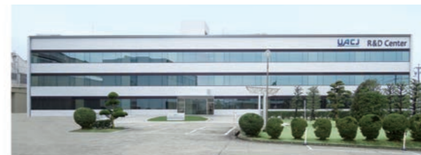
リニューアルされたR&Dセンター。外観はアルミハニカムパネル製だ。
